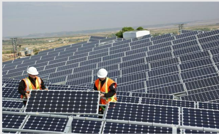
Imagen de los últimos trabajos de instalación
