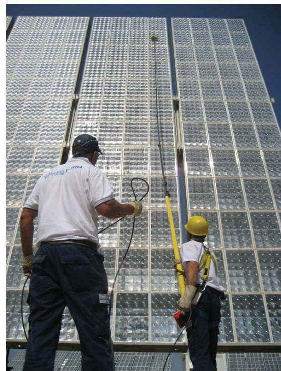
Operarios limpian uno de los módulos solares del Parque Solar de Villafranca
