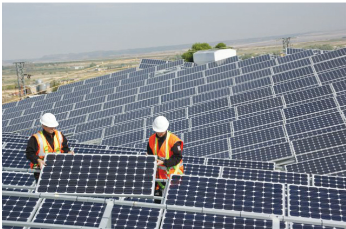
Operarios de Parques Solares de Navarra, en la instalación de 'La Oliva'
