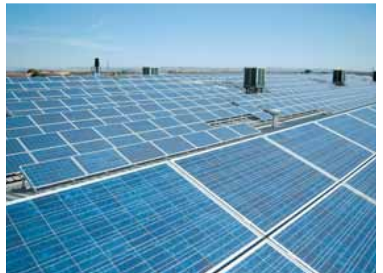
Imagen del tejado solar que se ha instalado en Cascante.
