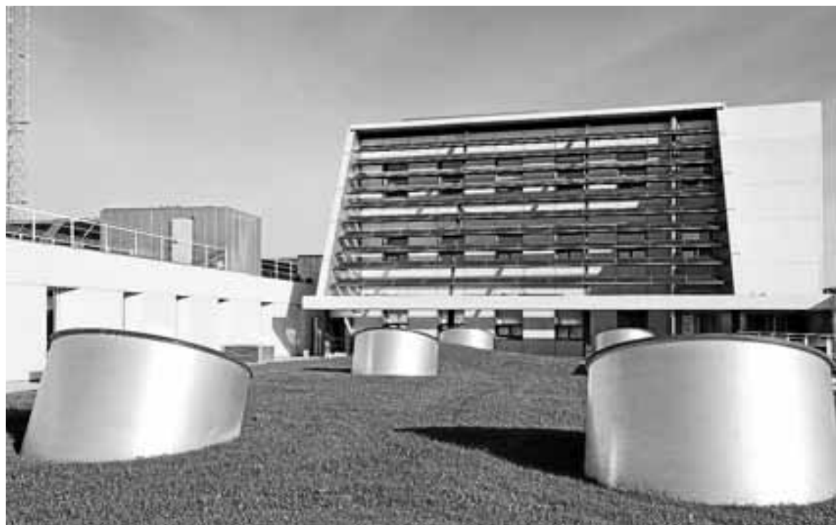
Exterior del Centro Nacional de Energías Renovables. FOTO: ARCHIVO
